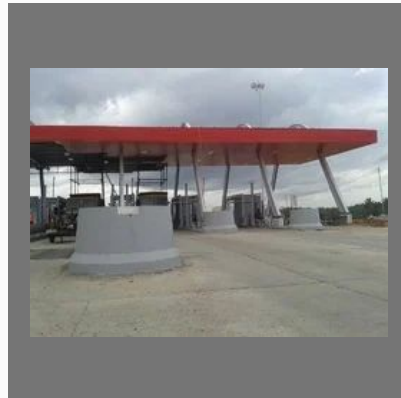
Lake & Hill False Ceiling
