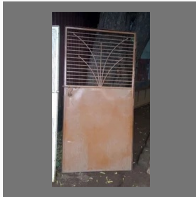
Safety Door Fabrication
