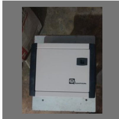
10 Way Double Door Havells Type MCB Box
