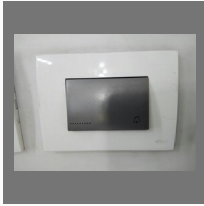
Electrical Door Bell
