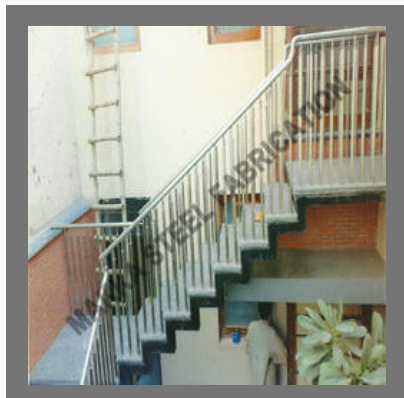
M. S. Staircase with S. S. Steel Railing
