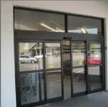
Door Automation System
