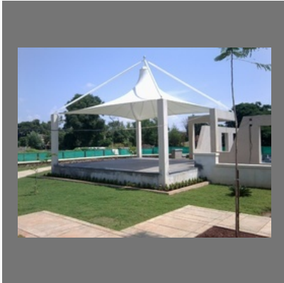
Tensile Membrane Structure
