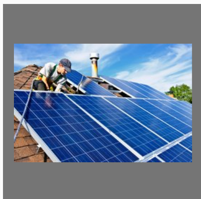
Solar Photo Voltich
