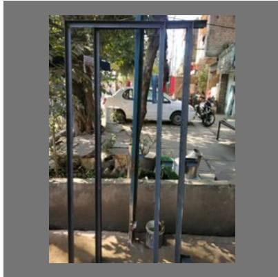
Iron Door Frame
