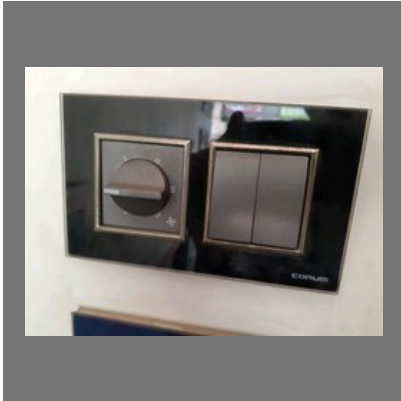
Fan Regulator Switch
