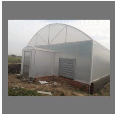
Fan & Pad Greenhouse Structure
