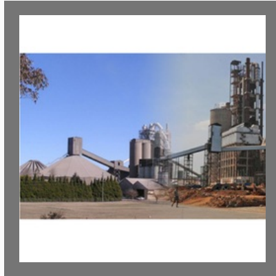
Mini Cement Plant
