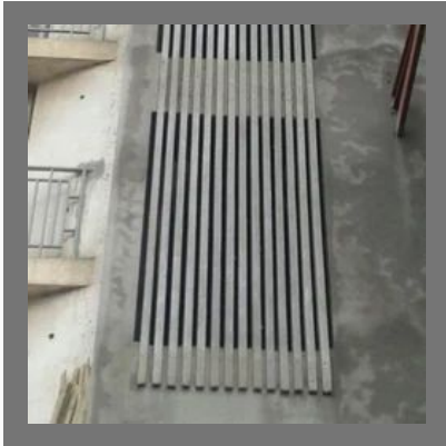
Concrete RCC Fins
